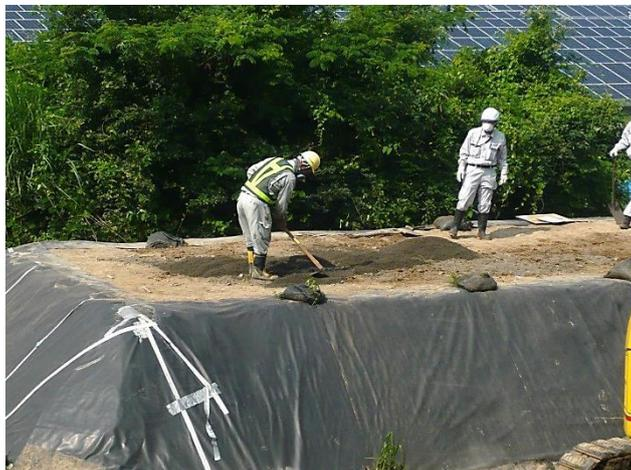
⑪ 防水シートをかぶせ、熱で溶接して完了です
