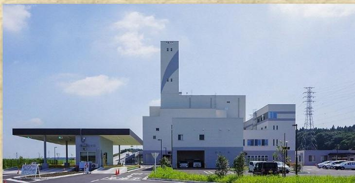
可燃ごみの焼却のほか、資源ごみの中間処理などを行っています。焼却で発生した熱は併設の温浴施設に、排ガスは発電に利用しています。屋上には太陽光パネルを設置しています。
