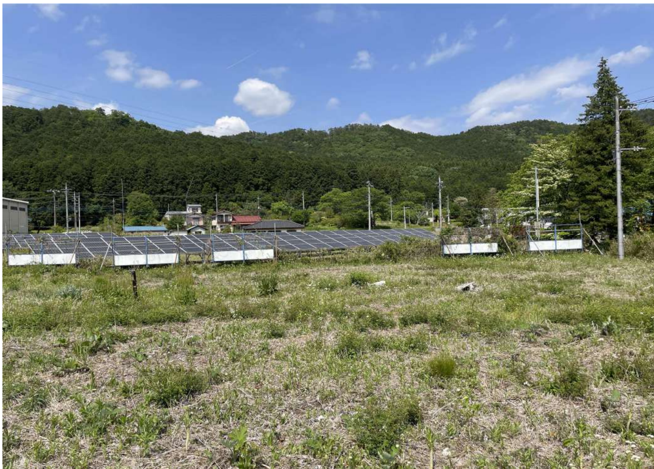
画地① 敷地中央部から北部
