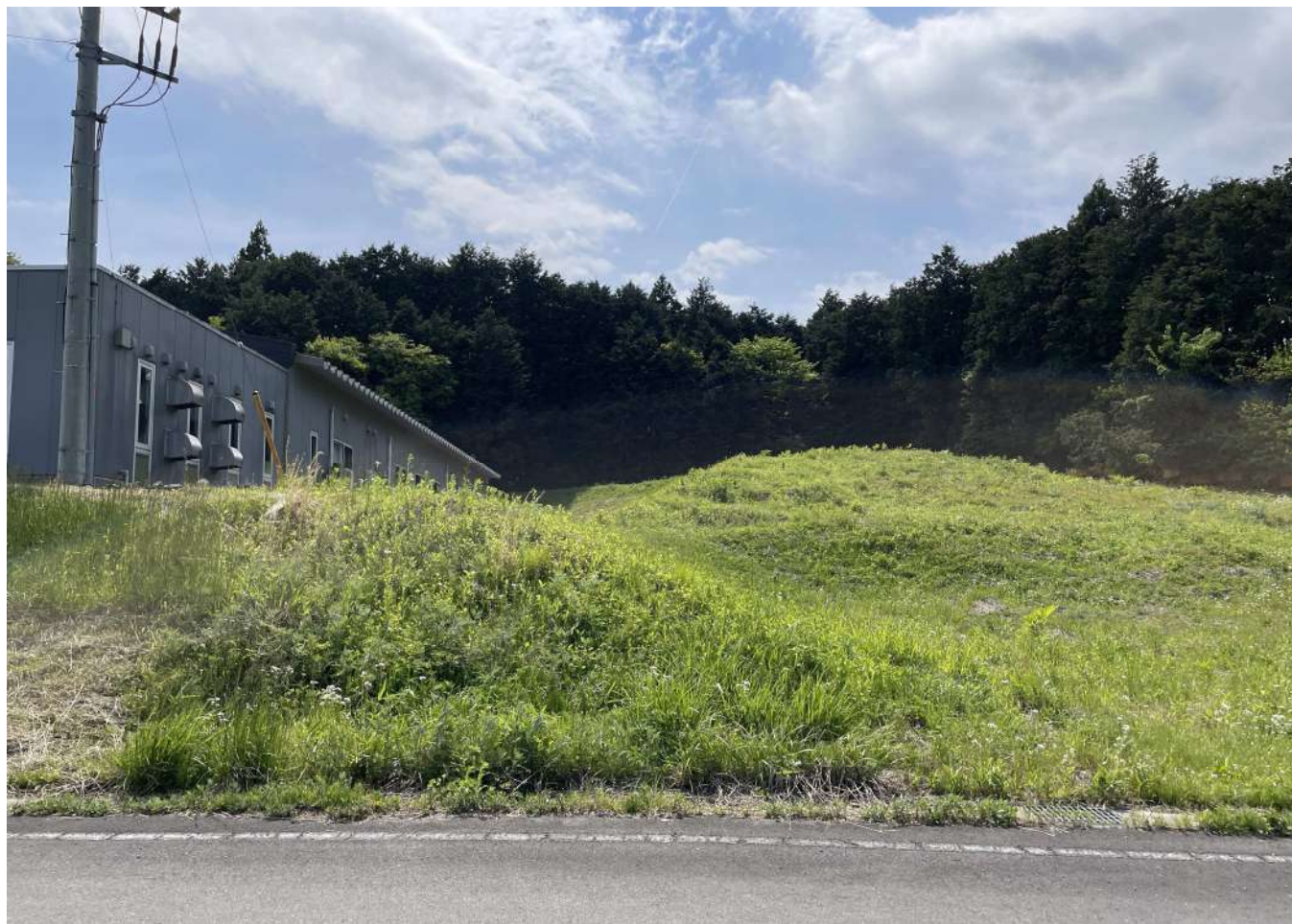
画地① 前面道路から隣接工場北部
