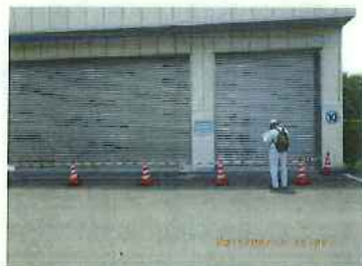
保管場所B,C： 倉庫（シャッター閉） 前面にカラーコーン、バーを設置。
