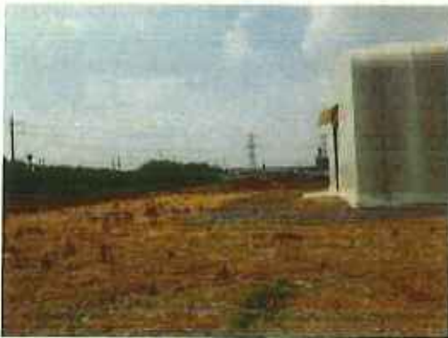
収納テント倉庫西側状況
