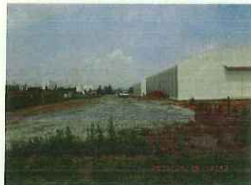
収納テント倉庫北側状況
