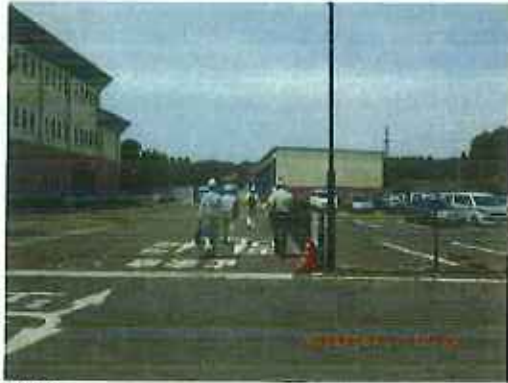
保管場所A： 資源回収ストックヤード（正面の建屋）
