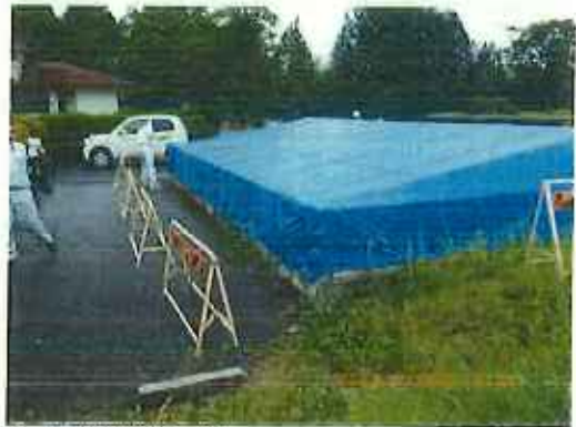
被覆シートに損傷なし①
