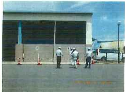
保管場所A： 資源回収ストックヤード前面 ・高さ約2mの木製ついでてを設置
