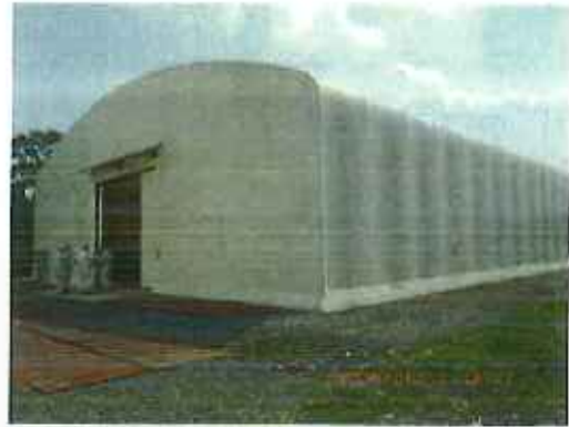
収納テント倉庫全景
