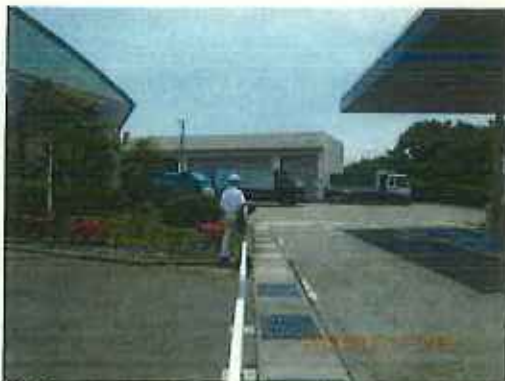
保管場所B,C： 倉庫（正面の建屋）
