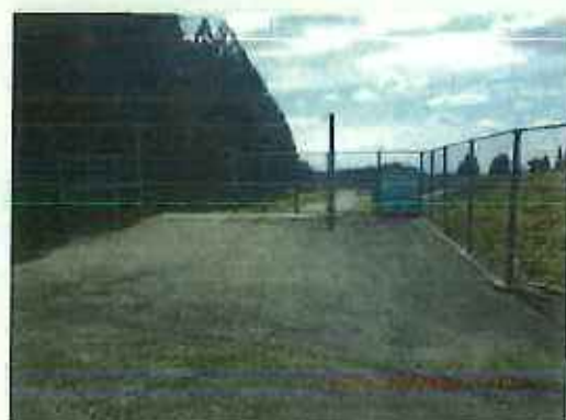
保管場所がある天日乾燥床の出入口(施錠あり)及び周囲の囲いフェンス
