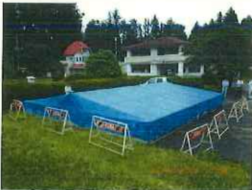
被覆シートに損傷なし②
