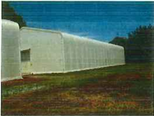
仮設テント全景 奥が指定廃棄物+8,000Bq/kg未満 手前は8,000Bq/kg未満専用
