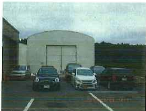
Aドーム搬入口前（立入禁止の表示のウマの前を出入り業者の 駐車スペースとして利用されている。）
