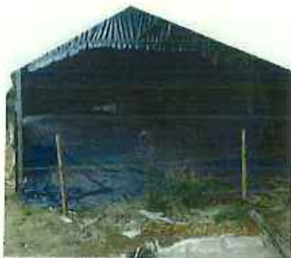
ハウス内指定廃棄物保管状況
