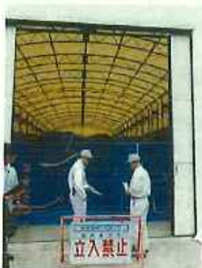
Aドーム内指定廃棄物（鉛入りシートで覆っている。）
