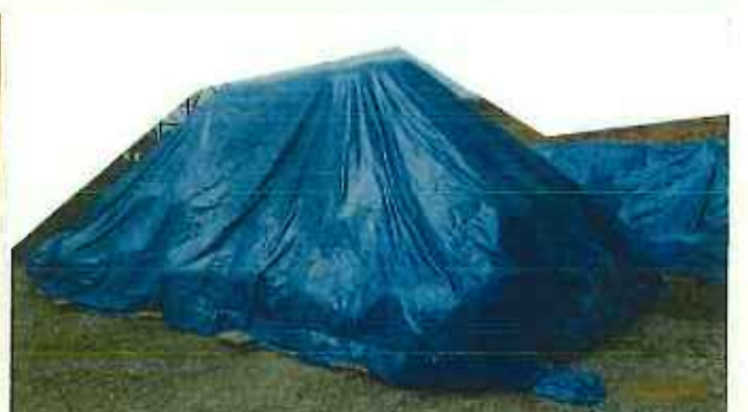
三段横みにして勾配をきつくし、雨水がシートに貯まらないようにした。
