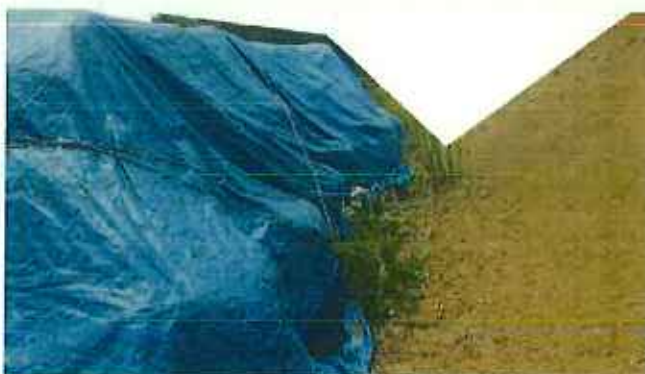
法面が崩れているが、指定廃棄物にかかってはいない。
