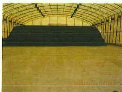
テント内保管状況 穴や破れなし。 浸出水などは見られない。
