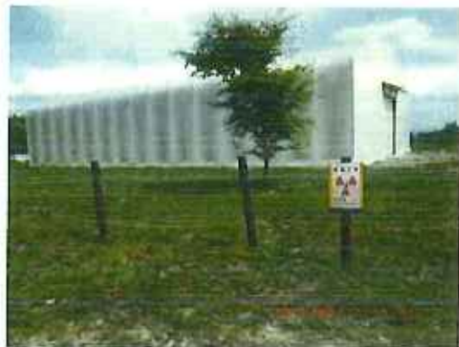
保管テント全景
