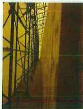
ドーム内コンクリート壁
