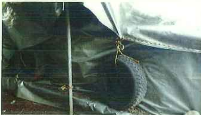
トラロープ押さえのため廃タイヤを使用
