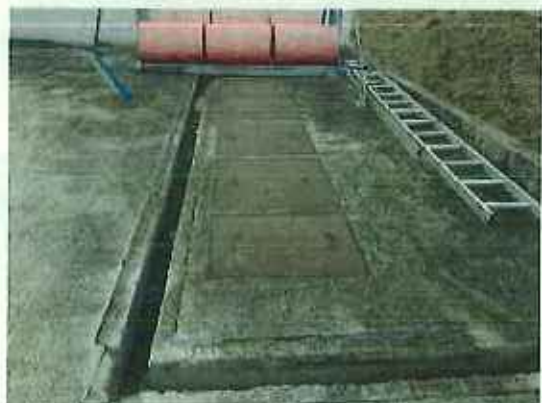
北側の集水ピット
