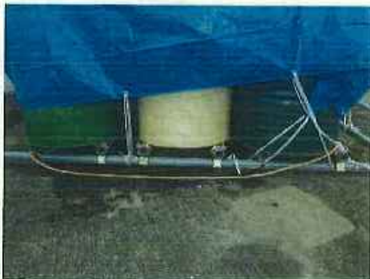
床コンクリートの上に単管パイプ による架台
