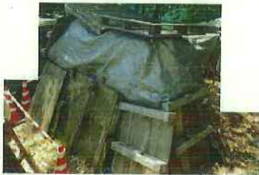
少量保管であり、パレットでシートの飛散防止。カラーコーンにバー設置
