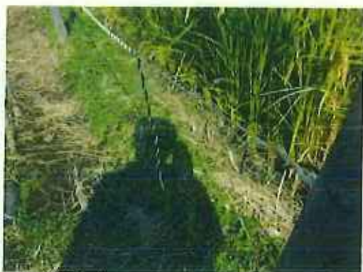
トラロープが切れかけている
