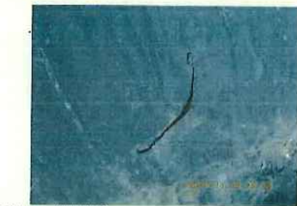
遮水シート破れあり
