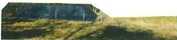
保管場所 (遠景)
