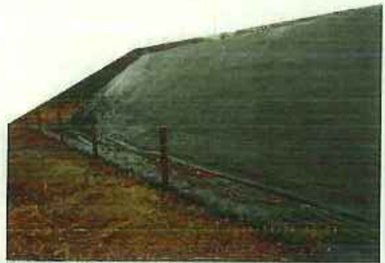
保管場所側面（囲い シート押さえ土のう）
