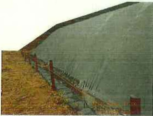
保管場所側面（囲い シート押さえ土のう）
