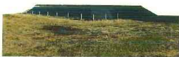
保管場所 (遠景)
