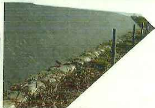
保管場所（囲い）トラロープが2間分外れている
