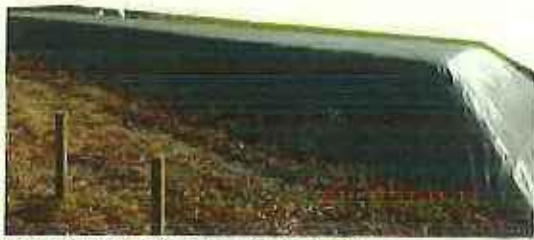
保管場所（上部）水たまりはみられない
