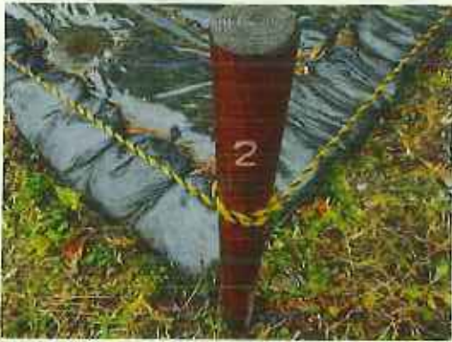
杭&トラロープ
