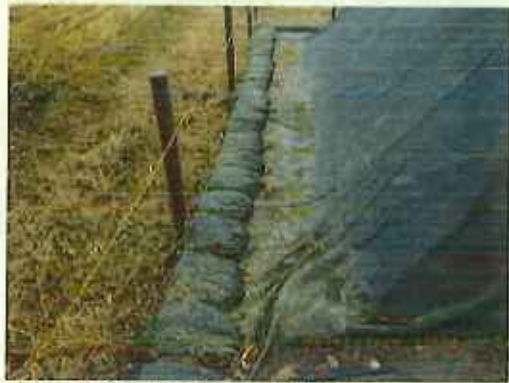
杭&トラロープ、土のうでシート押さえ
