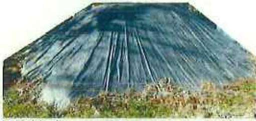
保管場所（遠景）
