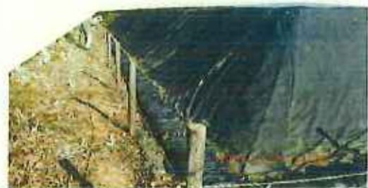
保管場所（囲い）水たまりは認められない
