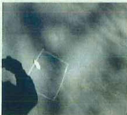
遮水シート穴、破れ等補修
