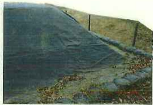
杭&トラロープ、土のうでシート押さえ
