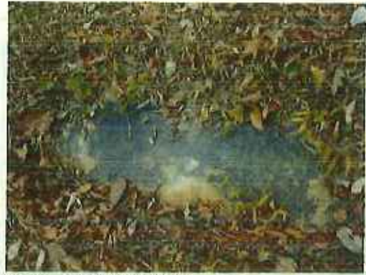
遮水シート 2014/11/19撮影 囲いのロープは撮影後設置
