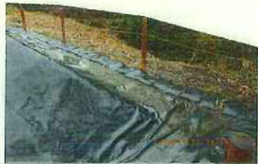
遮水シート押さえの土のう
