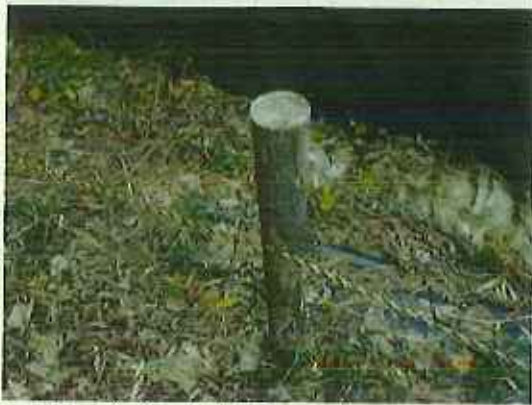
杭&トラロープ、シート押さえ
