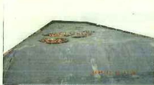
保管場所上部(若干の水たまり有り)
