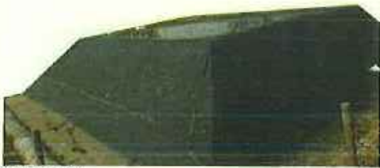
保管場所(上部)
