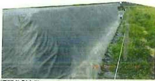
保管場所北側全景
