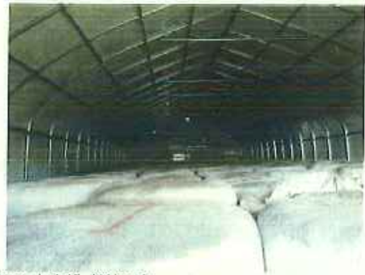
仮設テント内部（稲わら）
