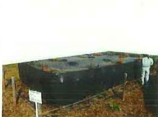
堆肥保管場所上部
