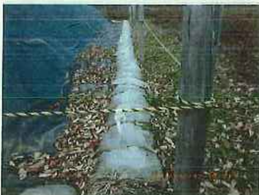
トラロープによる囲いと土のうによるシート押さえ。
