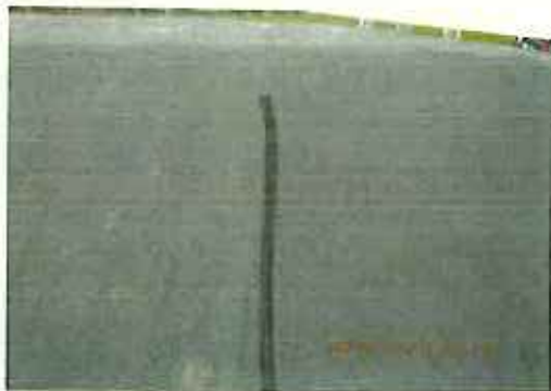
はがれの補修箇所
