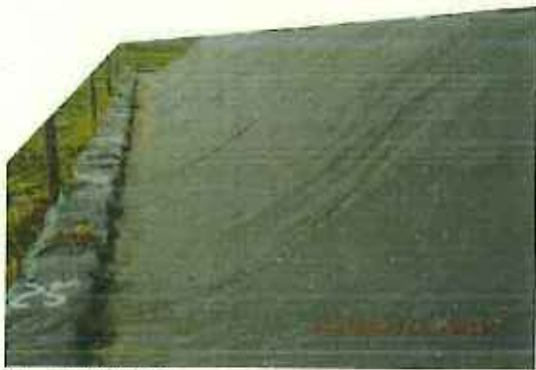
遮水シート補修完了
