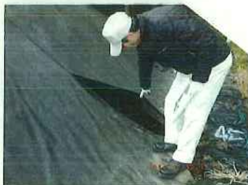
牧草のシートの接着が離れている。(数カ所有り)
