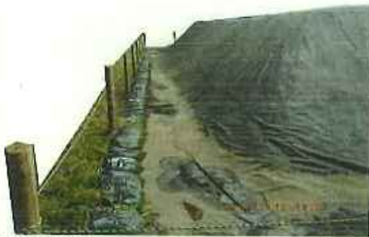
杭、トラロープ、 シート押さえ土嚢の状況
