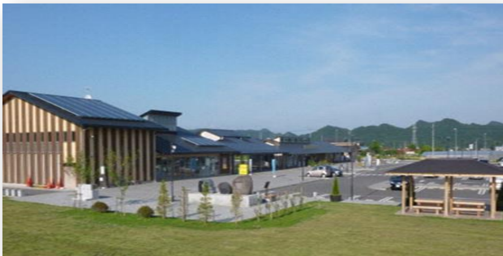
○道の駅「湧水の郷しおや」交流館に設置されている蓄電システムと太陽光発電設備
