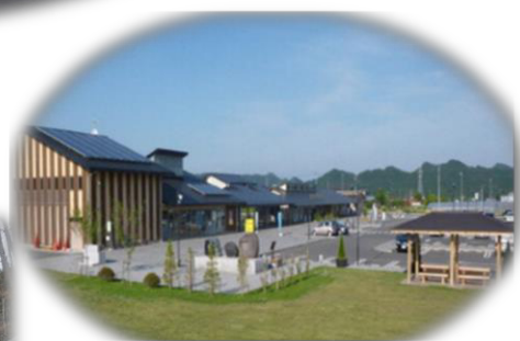
道の駅湧水の郷しおや (太陽光パネル・蓄電池完備)
