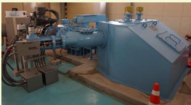
箱島湧水の水車発電機（青い装置全体）
