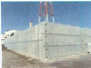
ボックスカルバートの設置
