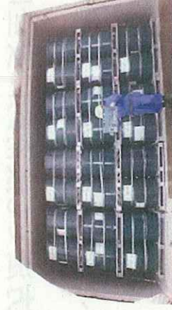
(焼却灰をドラム缶に詰めコンクリートカルバート内で保管)
