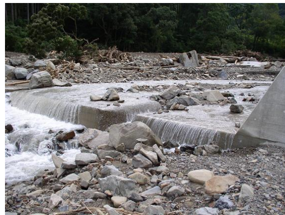
スリットダムでの堆砂
