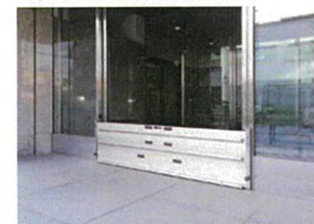
浸水対策④ 防水パネル設置例
