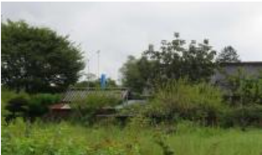
←西方から「東方向」を撮影 ＜左の建物は「附属建物 符号1」＞
